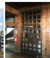
松江城天守の木製格子壁による補強
