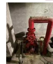
老朽化した消火ポンプの更新
