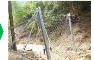
簡易な構造物による応急対策
