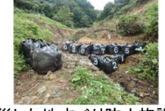
被災した地すべり防止施設での二次災害防止対策
