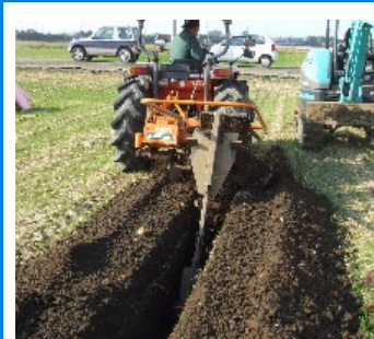
暗渠排水の整備
