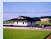
農業集落排水施設
