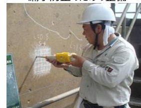
老朽化した施設の機能診断
