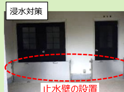
止水壁の設置
