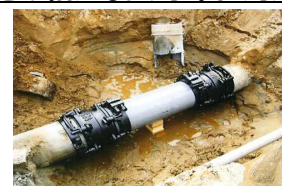
漏水防止のための整備
