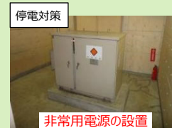
非常用電源の設置
