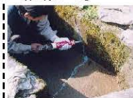
水路のひび割れ補修
