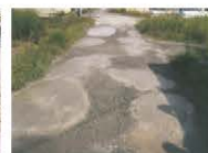
農道の窪みの補修
