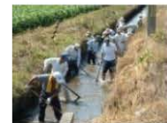
水路の泥上げ
