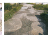
農道の窪みの補修
