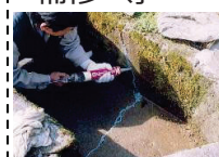
水路のひび割れ補修
