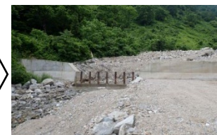
治山ダムに異常堆積した土石・流木の除去
