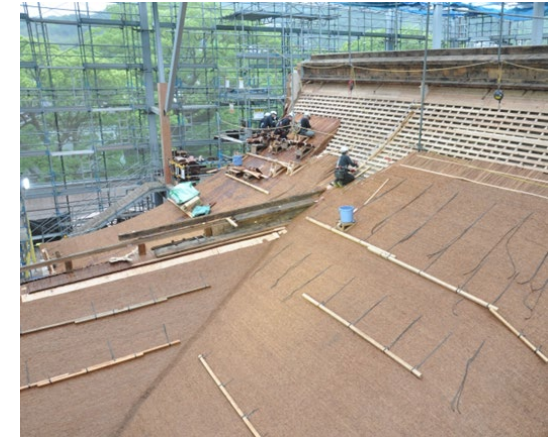
<建造物維持修理の様子> 重要文化財 大宰府天満宮本殿 屋根葺替え（福岡県）
