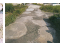
農道の窪みの補修
