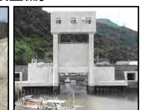
津波・高潮対策としての水門整備
