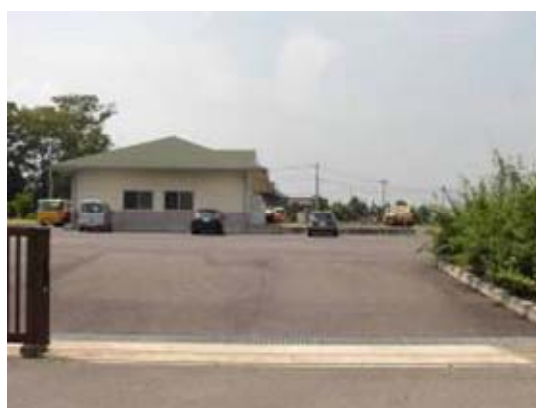
加須市大越地区の農業集落排水処理施設
