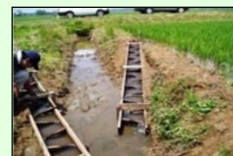
水田魚道の設置 (地域環境の保全)
