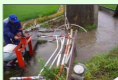
異常気象等後の 見回り・応急措置
