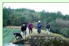
ため池の点検 (日常の管理)
