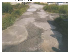
農道の窪みの補修
