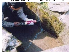
水路のひび割れ補修
