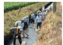
水路の泥上げ
