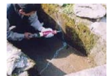
水路のひび割れ補修
