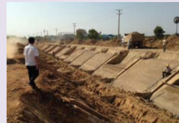
土水路の改修工事
