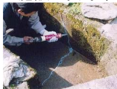
水路のひび割れ補修
