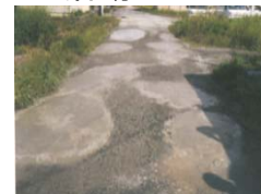
農道の窪みの補修
