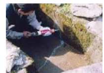
水路のひび割れ補修
