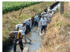
水路の泥上げ
