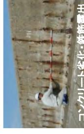
コンクリート劣化・鉄筋露出
