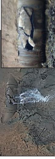
管水路における漏水事故 PC管の劣化
