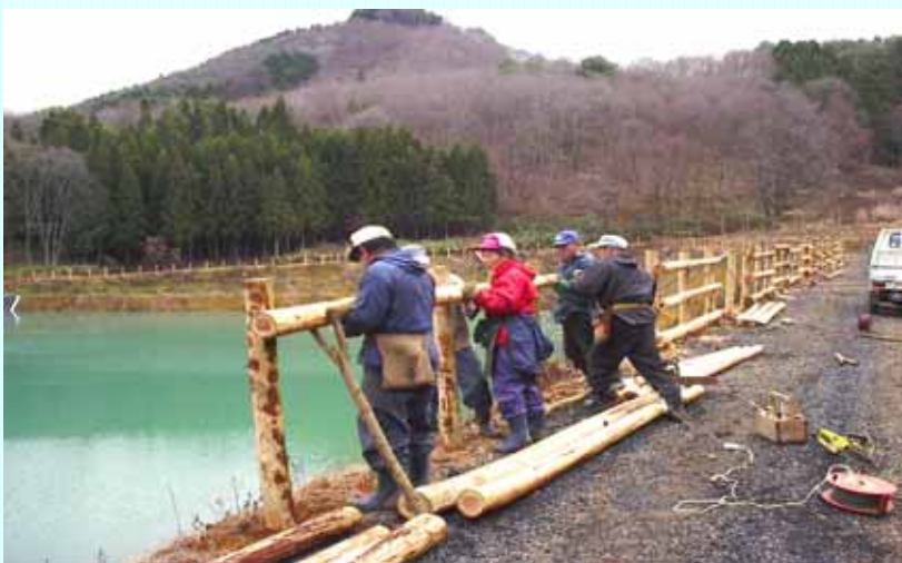
転落防止木柵の設置
