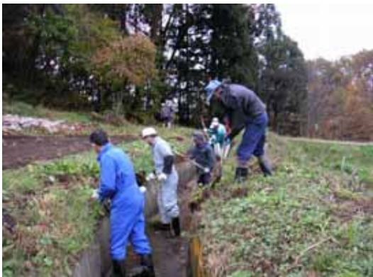
蓋を設置するため水路天端の土を取り除く
