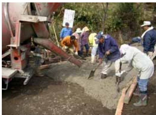
生コン車からコンクリート打設
