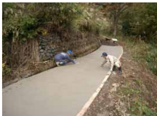
金ゴテによる仕上げ
