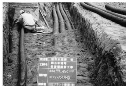
図 4.1-3 地中電線路工事（例）
