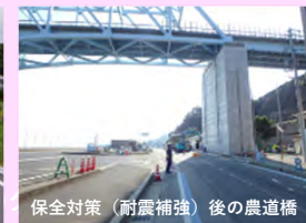
保全対策（耐震補強）後の農道橋
