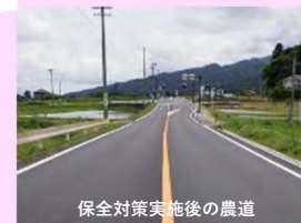
保全対策実施後の農道
