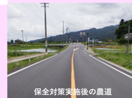
保全対策実施後の農道
