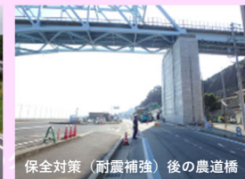
保全対策（耐震補強）後の農道橋
