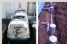
特定既存単独処理 浄化槽の撤去
