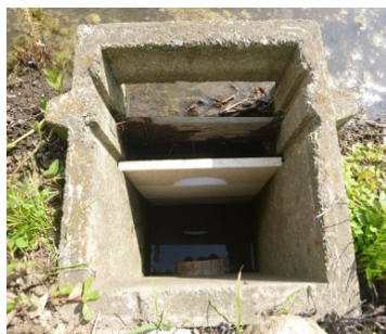
田んぼダムの取組例 (調整板の設置)
