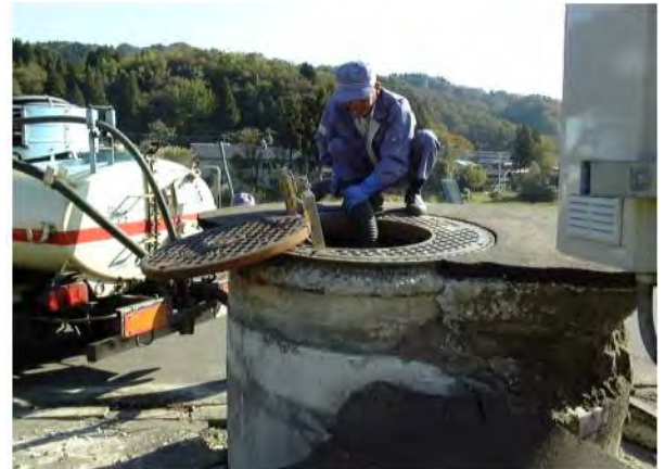
写真－3－5 管路マンホールの緊急措置 の状況
