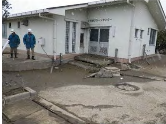
写真－3－3 汚水処理施設の緊急調査状況 (東北地方太平洋沖地震)
