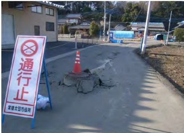
写真－3－4 管路施設の緊急措置の状況
