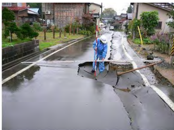
写真-3-1 管路の緊急点検・調査の状況
