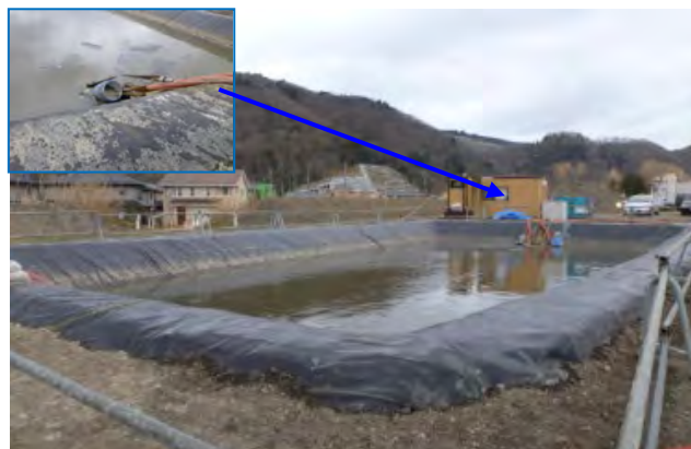
写真-4-8 仮設沈殿池及び仮設塩素混和槽
