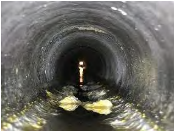
写真-5-3 二次調査（管口カメラ調査）による管路に変状がない状況（写真左、光が丸く見える）と管路が上方向にたるんでいる状況（写真右、光が見えない）
