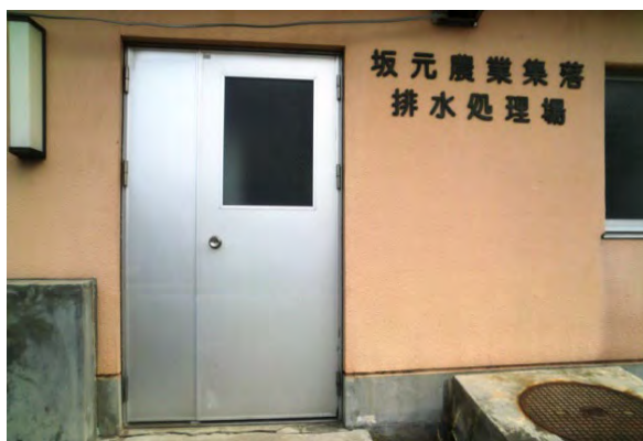
写真-6-5 汚水処理施設建屋 ドアガラリなし
