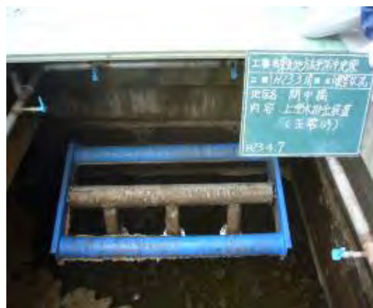
写真-5-7 上澄水排出装置の変形
