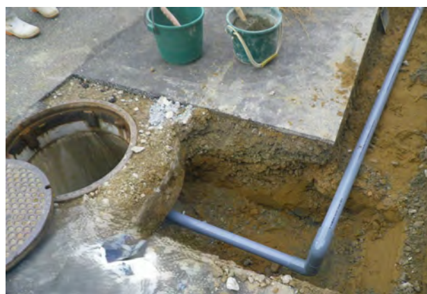
写真－４－３ 仮設ポンプによる応急復旧
