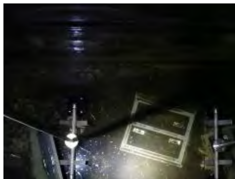
写真－5－12 左：流量調整槽の土砂混入（污水計量槽の四角堰） 右：水槽内への覆蓋の落下（汚泥貯留槽）
