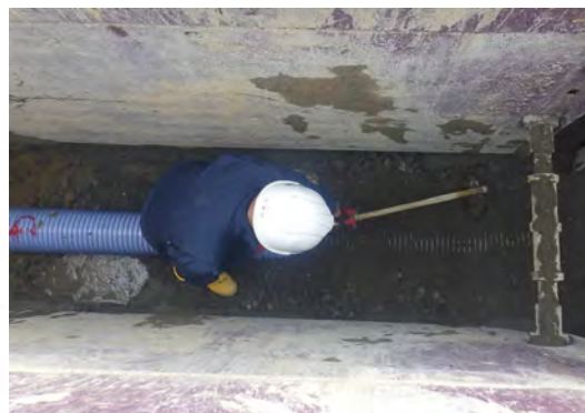
固化改良土埋戻工法による施工
