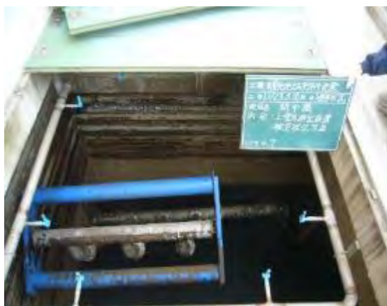
写真-5-7 上澄水排出装置の変形
