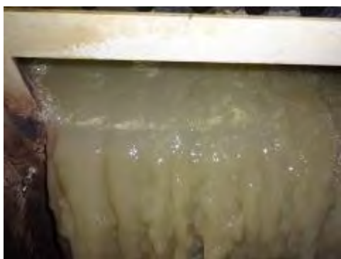
写真－5－12 左：流量調整槽の土砂混入（污水計量槽の四角堰） 右：水槽内への覆蓋の落下（汚泥貯留槽）
