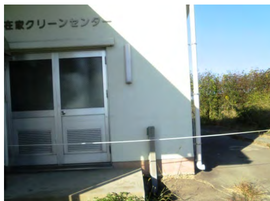
写真-6-6 汚水処理施設建屋 ドアガラリあり
