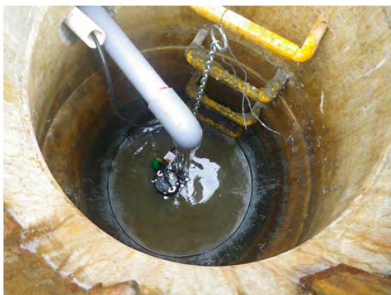
写真－４－３ 仮設ポンプによる応急復旧
