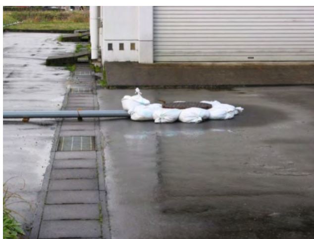
写真－５－９ 流入管路の応急復旧の状況
