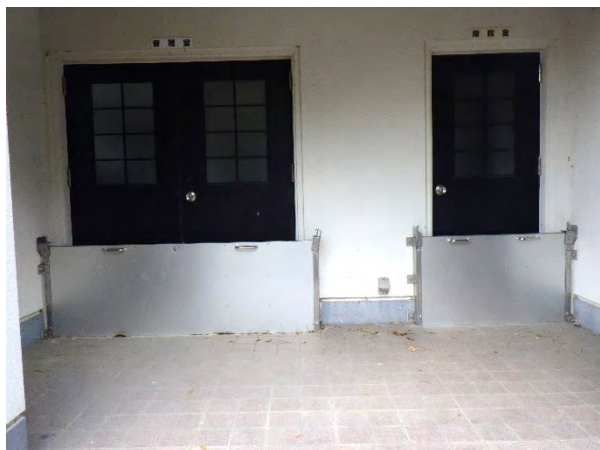
写真－６－７ 汚水処理施設建屋 止水板の追加設置
