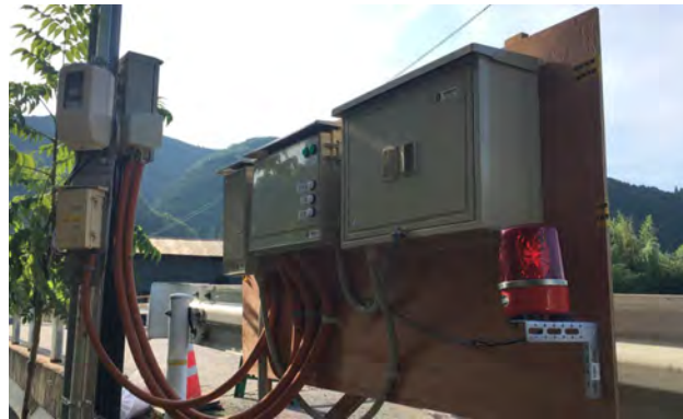
写真－5－10 応急仮工事（中継ポンプ仮設盤）
