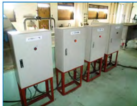
津波で被災した汚水処理場（写真左）と仮制御盤（写真右）による暫定的な汚水処理再開
