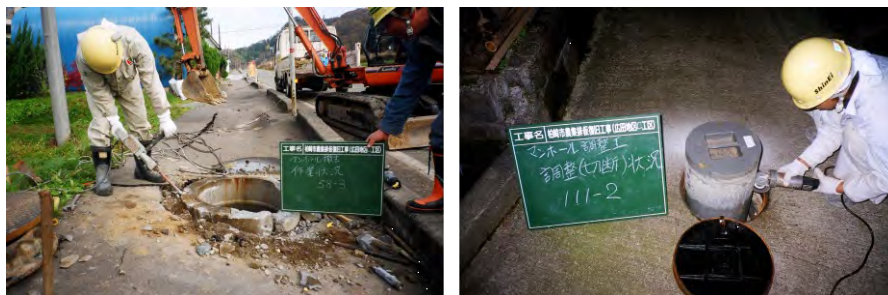
写真-5-8 マンホールの切り下げ状況
