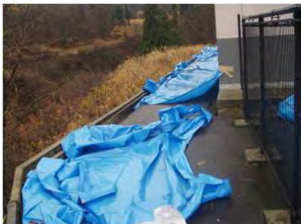
写真－3－6 汚水処理施設周辺の崖崩れ保護 (写真の左部分は崖になっており場内の一部が崩壊したため、ブルーシートで崩壊防止策をとるとともに、立入禁止措置が行われている。)
