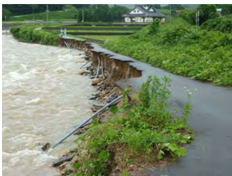
写真－5－11 応急仮工事（左：管路被災状況、右：仮設道路と仮配管）
