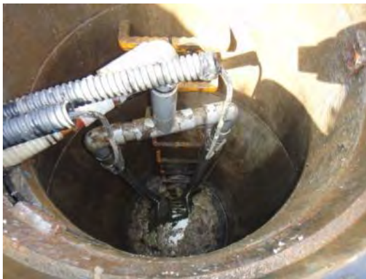
写真-4-1 仮設ポンプによる対応
