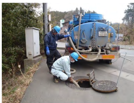
写真-4-6 バキューム車による滞留汚水搬出
