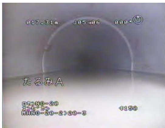
写真-5-5 管内カメラ（テレビカメラ）による管路内の滞水状況（写真左）とコンクリート管の管体側面のひび割れ及び浸入水の状況（写真右）
