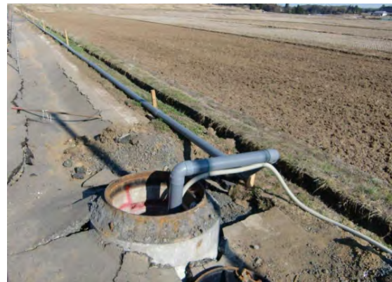
写真-4-2 仮設配管による対応
