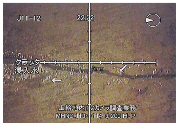
写真-5-5 管内カメラ（テレビカメラ）による管路内の滞水状況（写真左）とコンクリート管の管体側面のひび割れ及び浸入水の状況（写真右）
