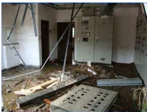
津波で被災した汚水処理場（写真左）と仮制御盤（写真右）による暫定的な汚水処理再開
