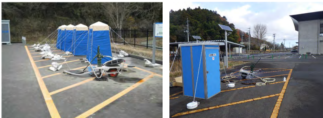
写真-6-14 宮城県東松島市（大塩市民センター）のマンホールトイレ （左：東日本大震災時のテント式、右：現在のパネル式）
