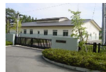
湯本南方処理場（花巻市）
