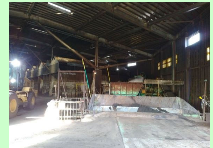
肥料化施設内の発酵設備
