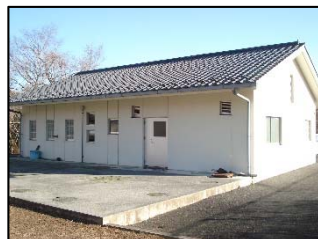
▼污水处理施設(水槽)
