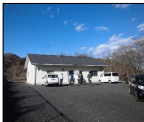
▼污水处理施設
