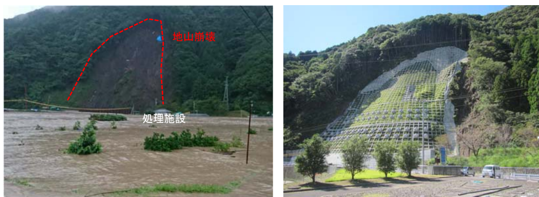
写真－６－６ 左：近傍地山の崩壊、右：法面保護工（右）
