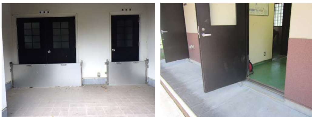
写真－６－５ 汚水処理施設扉
