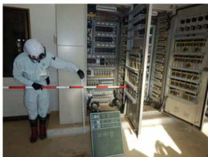
写真－５－１ 電気設備（左：汚水処理施設制御盤、右：計装盤）の状況調査
