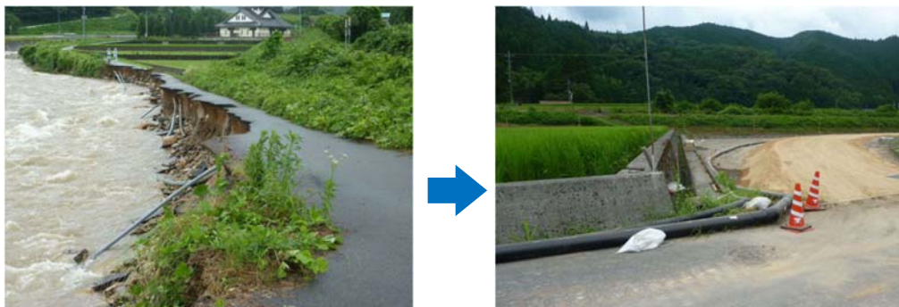
写真－５－６ 応急仮工事（左：管路被災状況、右：仮設道路と仮配管）
