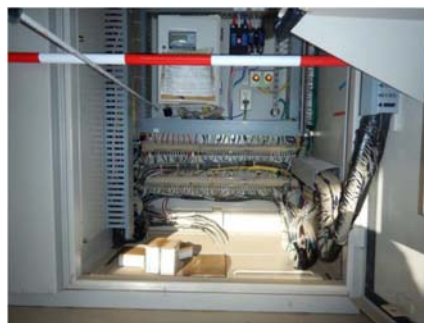
写真－５－１ 電気設備（左：汚水処理施設制御盤、右：計装盤）の状況調査
