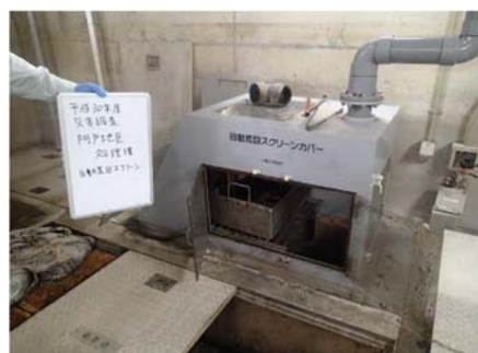
写真－５－２ 機械設備（左：ばっ気ブロワ、右：自動荒目スクリーン）の状況調査
