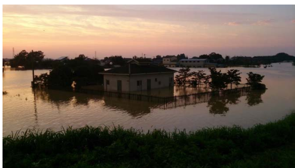
污水处理施設の浸水
