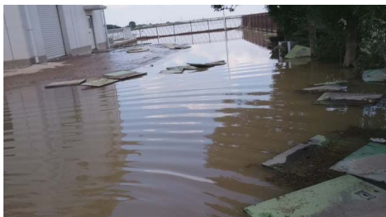
処理水槽点検蓋の流出
