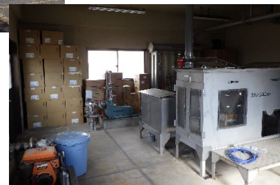
防災倉庫として活用しているスクリーン室（機器は洗浄して存置）
