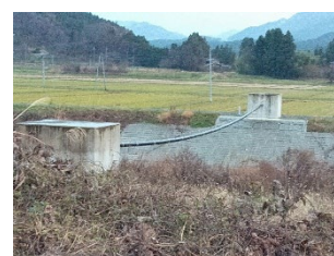
接続管路（吊配管工）
