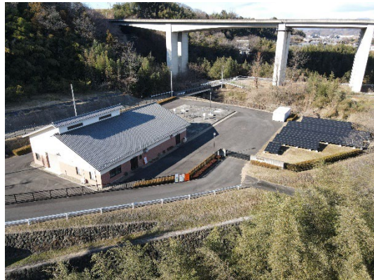
写真 4 - 4 - 5. 汚水処理施設への太陽光発電施設の設置例 (左：屋根置き型、右：架台設置型)
