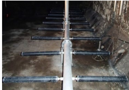
写真 1 - 3. 省エネルギー技術の導入（微細気泡散気装置の導入）
