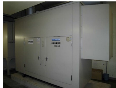
写真 1－7．浸水対策（汚水処理施設止水板）、右：停電対策（非常用発電設備）
