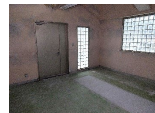
廃止処理施設プロワ室 (機器及び二次コンクリートを撤去し、資料倉庫に利用予定)
