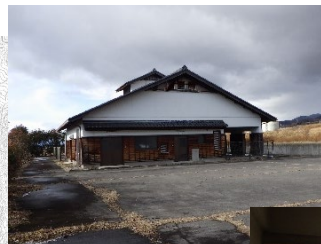
左：廃止した滋野地区建屋
