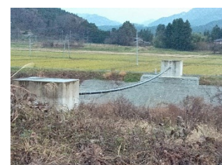
接続管路（吊配管工）
