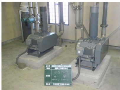
写真 1－5．省エネルギー技術の導入 （トップランナーモーター搭載型ブロワ）
