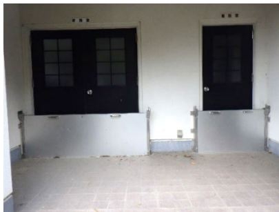
写真 1－7．浸水対策（污水处理施設止水板）、右：停電対策（非常用発電設備）
