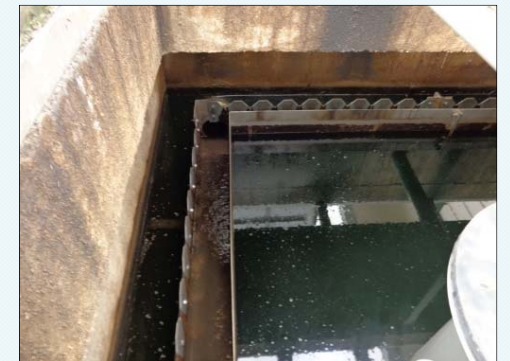
S-5: 変状なし(健全な状態)
