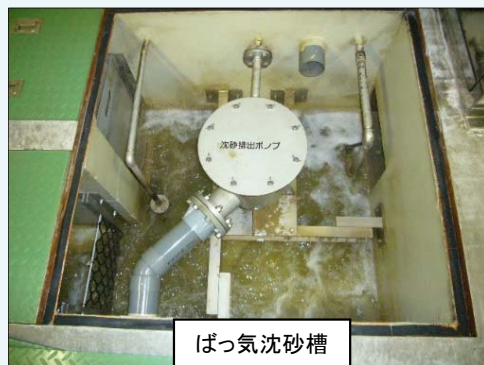
S-5: 変状なし(健全な状態)
