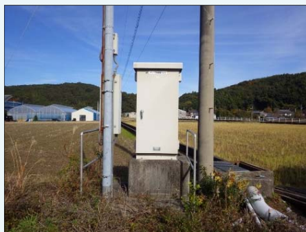
コンクリート基礎状態確認
