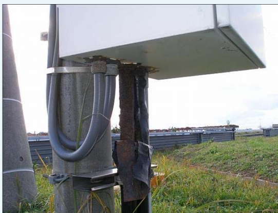
S-3: 変状あり(制御盤の劣化)
