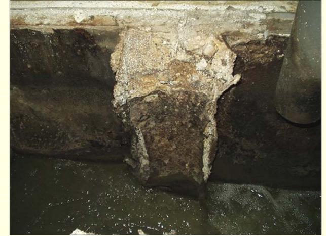
S-2: 顕著な変状あり(粗骨材の剥落)
