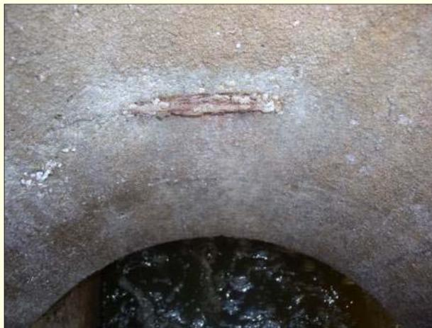
S-3: 変状兆候(部分的な鉄筋露出)
