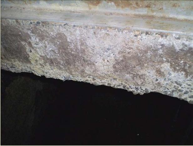
S-4: 変状兆候(細骨材の露出)
