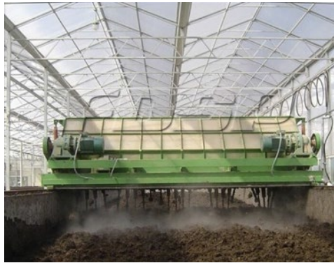
参考 7.2 開放式堆肥化設備
