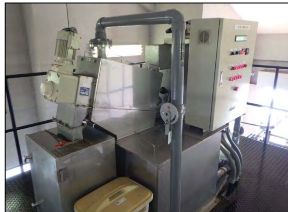
写真4 汚泥脱水機
