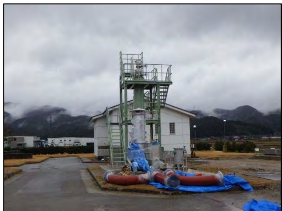
写真7 脱硫装置・余剰ガス燃焼装置（設置中）
