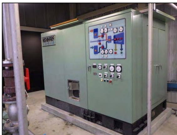
写真3 遠心脱水装置
