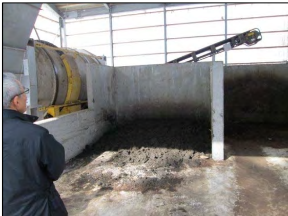
写真3 脱水污泥置場(中央)、一次発酵場(右)
