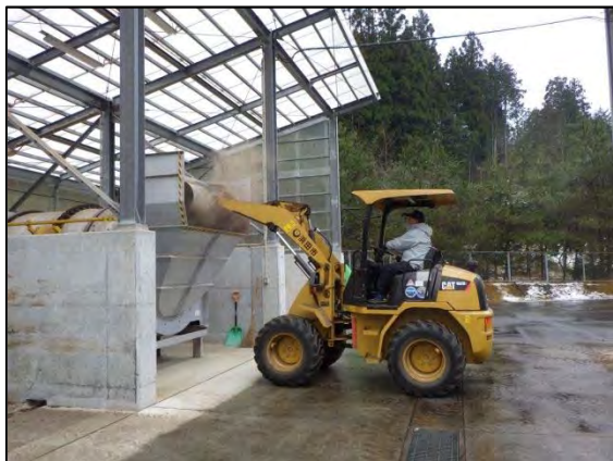
写真5 攪拌機投入（ホイールローダ）
