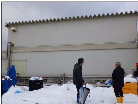
写真 3 ガスホルダー・発酵槽
