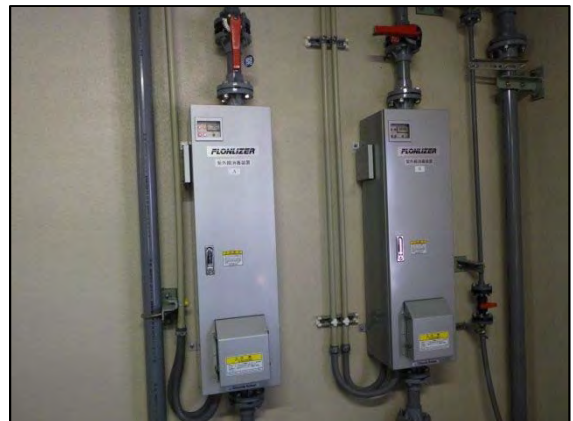
写真8 紫外線滅菌装置
