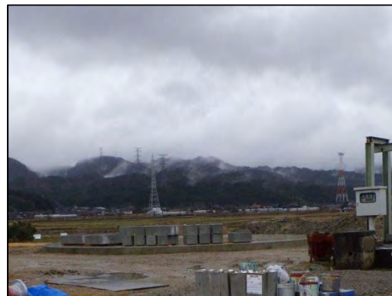
写真4 ガスタンク（建設中）
