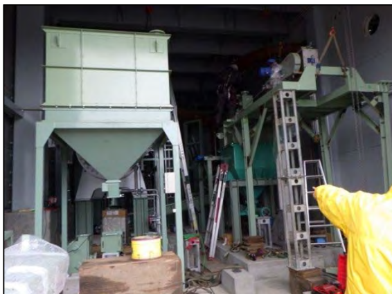
写真5 造粒・袋詰設備（設置中）
