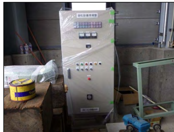
写真6 造粒設備現場盤（設置中）
