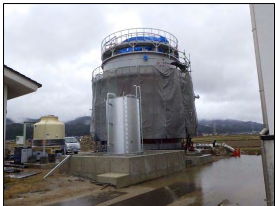
写真3 メタン発酵槽（建設中）
