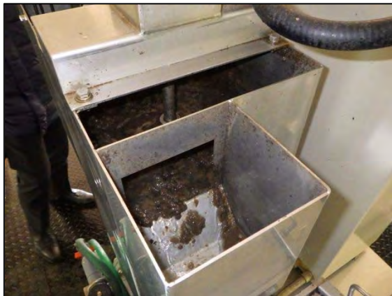
写真2 凝集剤添加後汚泥状況
