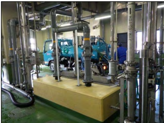
写真3 生し尿、浄化槽汚泥投入状況
