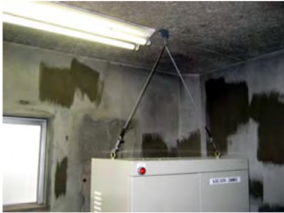
写真 4 1 制御盤の転倒防止 【制御盤の頂部支持】※7
