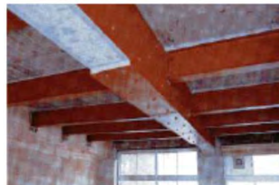
写真 3 5 炭素繊維及び鋼板巻き補強
