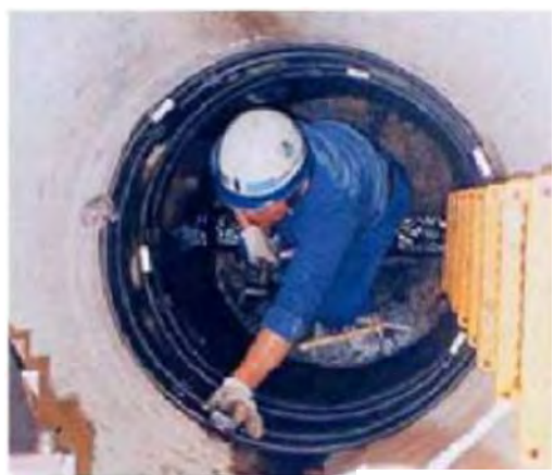
写真40 スリーブ(ステンレス+ゴム複合体)の設置 【人孔の継手部】※6
