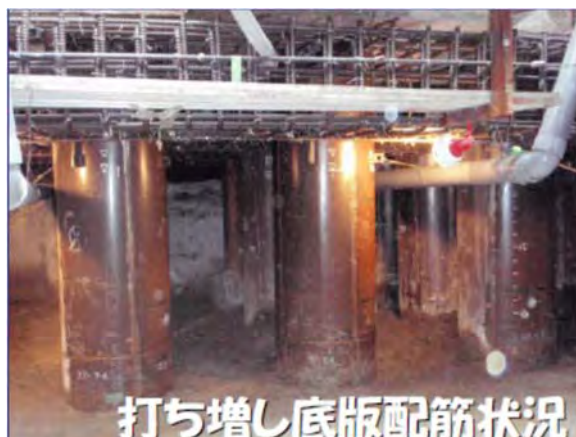
写真38 底版部のC o 打ち増し 【汚泥消化タンク底版部】※5
