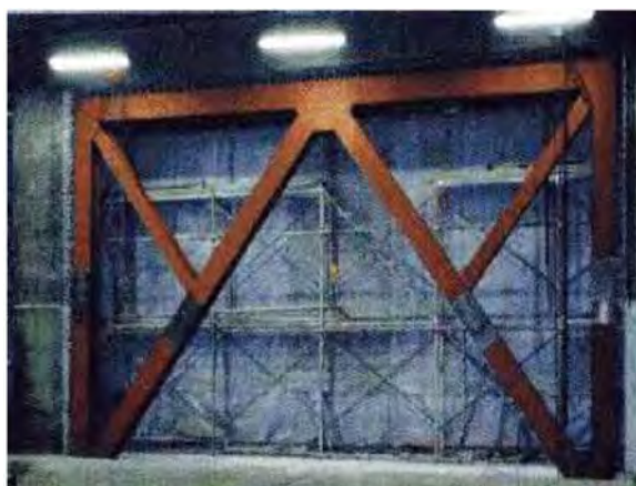
写真 3 3 鉄骨ブレースの設置
