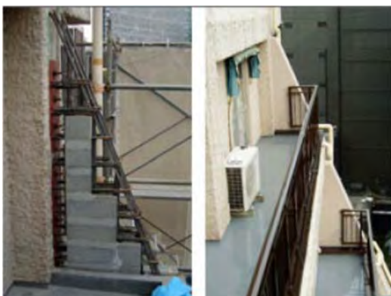
写真 3 2 バットレス補強の設置
