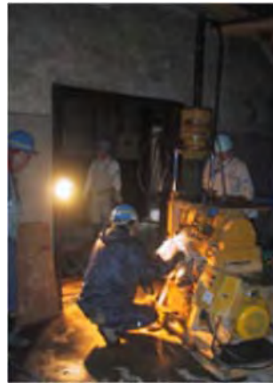
写真36 静的圧入締固め工法 【既設構造物の床版下部】※4
