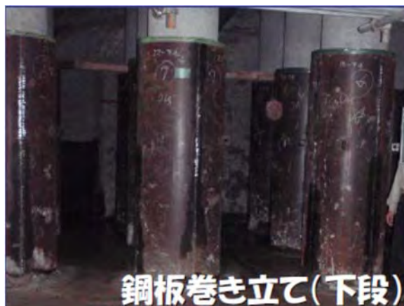
写真37 杭基礎部の鋼板巻き立て 【汚泥消化タンク基礎部】※5
