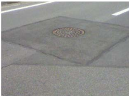
千葉県湾岸地域 2011.3.14撮影 東日本大震災直後に有効性を確認
