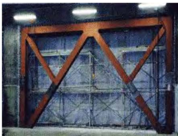
写真 3 3 鉄骨ブレースの設置
