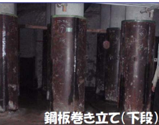
写真37 杭基礎部の鋼板巻き立て 【汚泥消化タンク基礎部】※5
