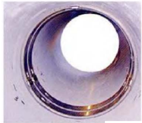
写真39 スリーブ（ステンレス+ゴム複合体）の設置 【管路の目地部】※6
