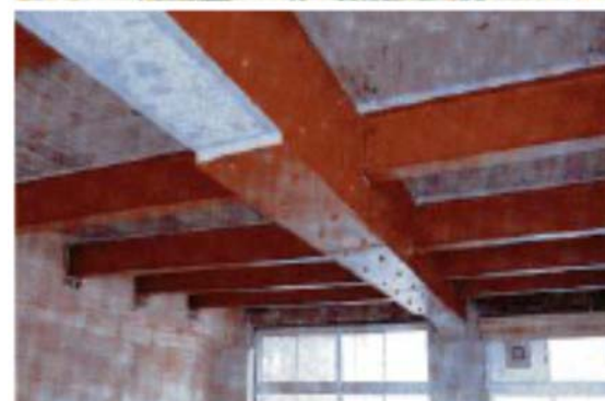
写真 3 5 炭素繊維及び鋼板巻き補強
