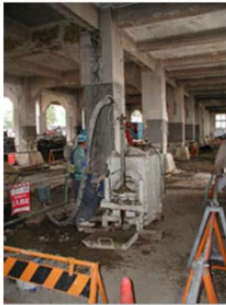
写真36 静的圧入締固め工法 【既設構造物の床版下部】※4
