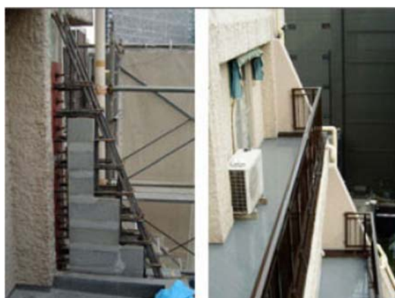
写真 3 2 バットレス補強の設置
