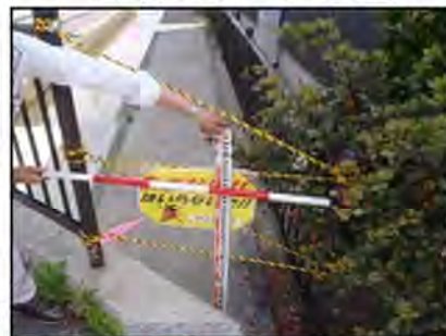
写真1 再発防止に向けた応急措置の例(応急ロープの設置)
