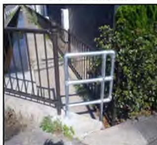
写真2 ハード対策(転落防止柵)
