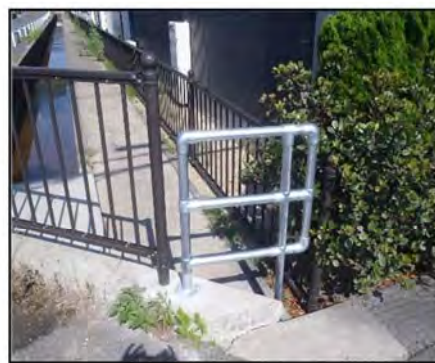
侵入防止柵を設置 (新潟県新潟市)
