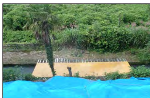
水路への仮蓋の設置
