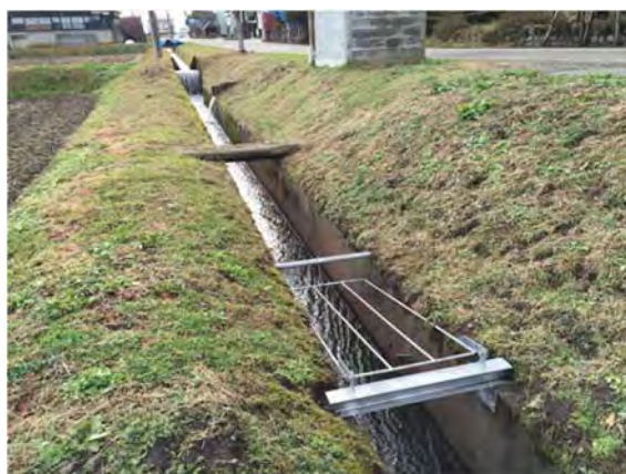
救助用スクリーンの設置
