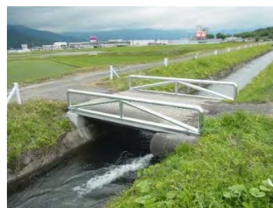
床板橋に転落防止柵を設置 (新潟県南魚沼市)
