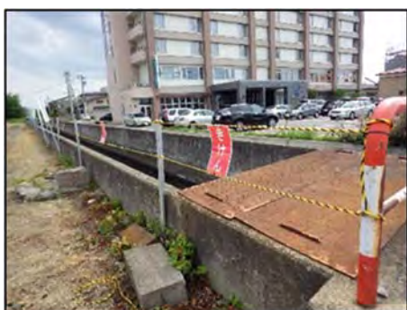
応急ロープの設置
