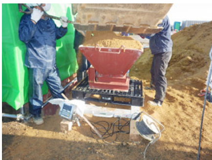
電子秤を使用した母材計量状況
