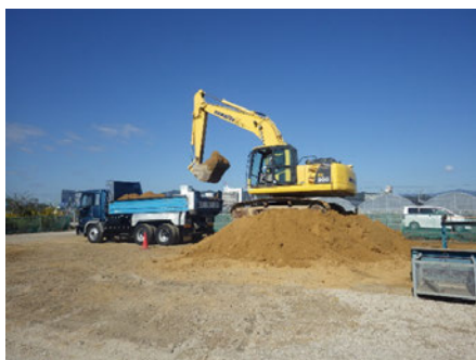
ベントナイト混合土 積み込み・運搬状況
