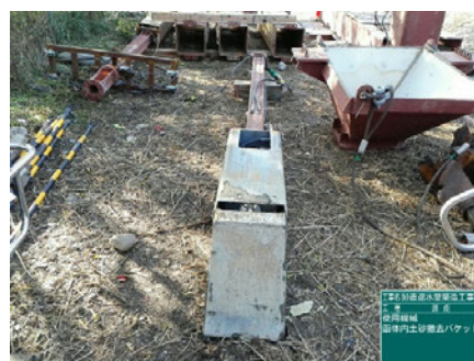
函体内土砂撤去バケット (油圧開閉式)
