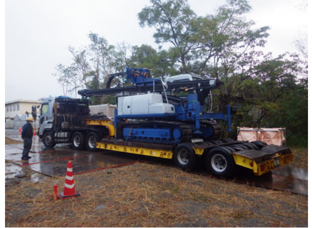
資機材搬入状況
