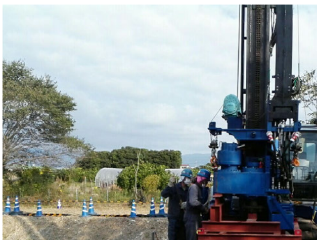
写真-7 アースオーガー⇒バイブロハンマーへの交換作業状況
