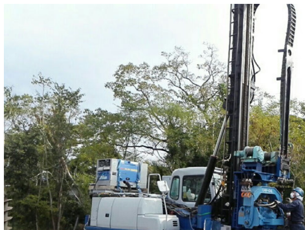
写真-7 アースオーガー⇒バイブロハンマーへの交換作業状況
