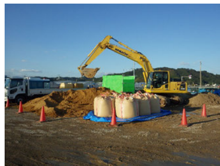
ベントナイト混合土練混ぜ状況
