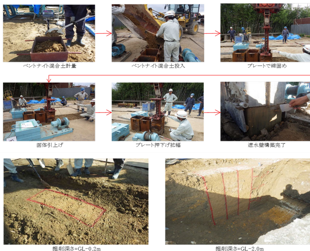
写真-4 函体打設工法試験打設状況写真
