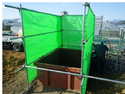
バックホウ攪拌用水槽 （防塵対策済）
