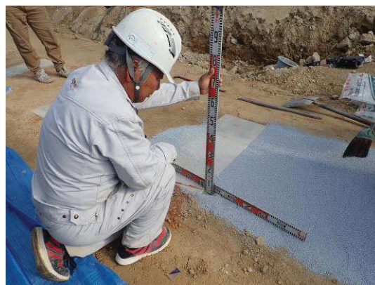
写真2 ベントナイト厚計測状況
