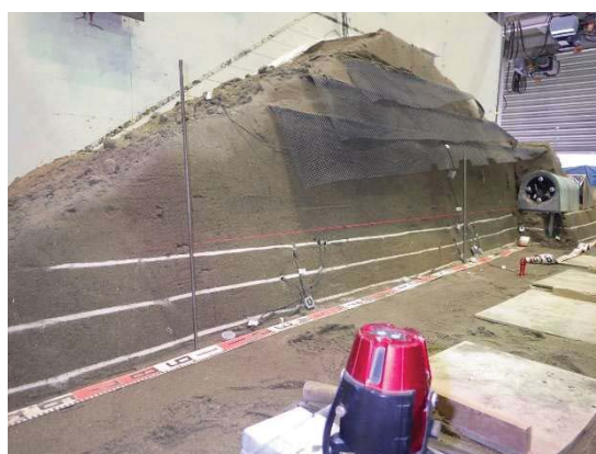
写真 4 ブロック撤去後
