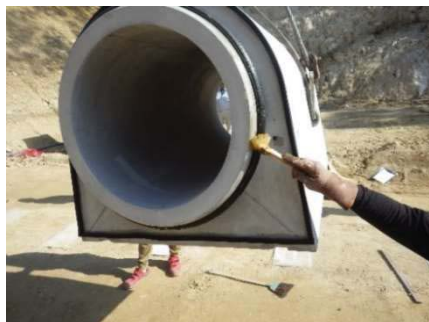
図-4.4.5(2) 耐震ゴムリングへの滑材塗布
