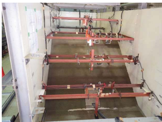
写真 1 堤体構築完了状況
