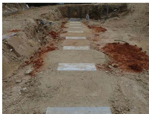
図-4. 4. 4(2) 基礎地盤の締め固め完了
