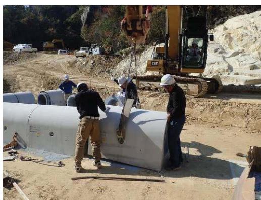
写真3 PCa 底樋管据付状況
