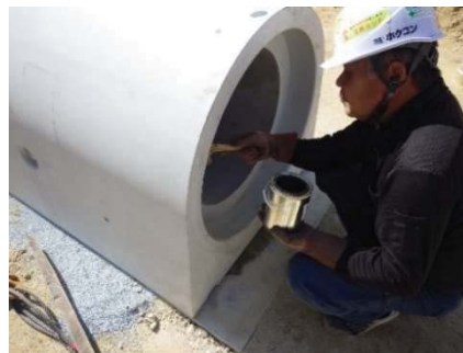
図-4.4.5(3) 凹側受け口への滑材塗布
