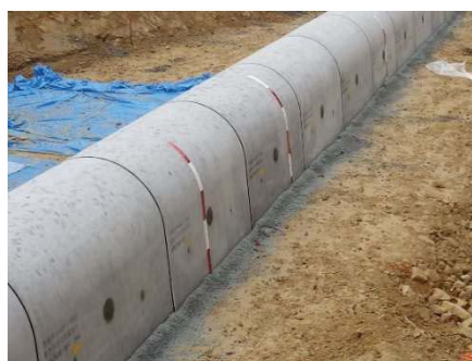
図-4.4.5(11) ベントナイト設置状況
