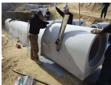
図-4.4.5(6) 標準製品の吊り
