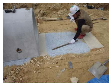
図-4.4.5(5) ベントナイト敷設
