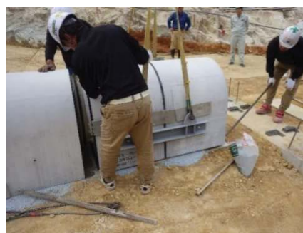
図-4.4.5(7) 拘束部製品の吊り
