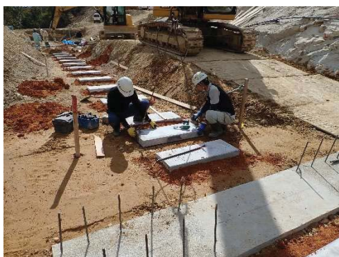
図-4. 4. 4(1) プレキャスト基礎板の据付
