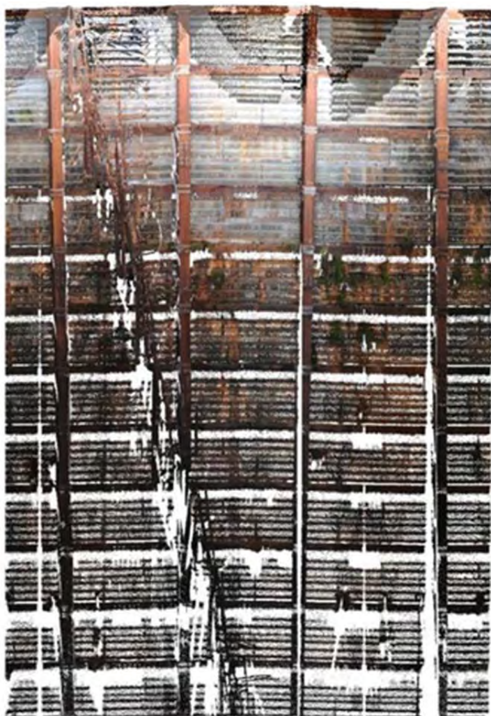
図 8-5 3D スキャナーによる縦 16 等分 RGB 展開図(地上設置型)
