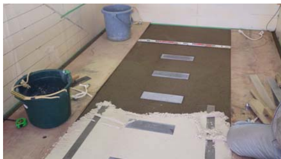
写真 25 基礎構築状況
