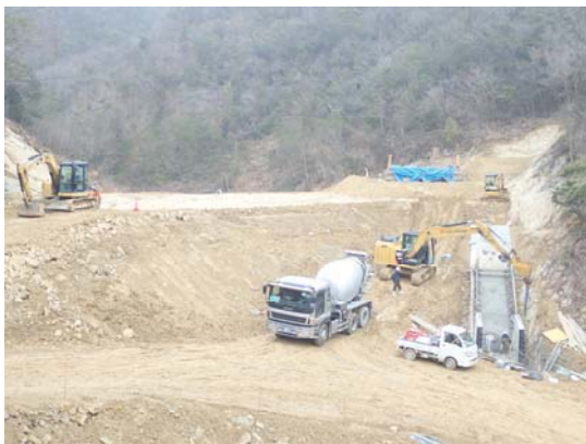
写真 36 堤体施工状況
