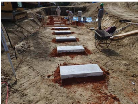
写真 31 PCa 基礎パネル設置完了状況
