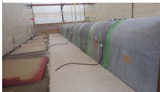
写真 26 ブロック敷設完了
