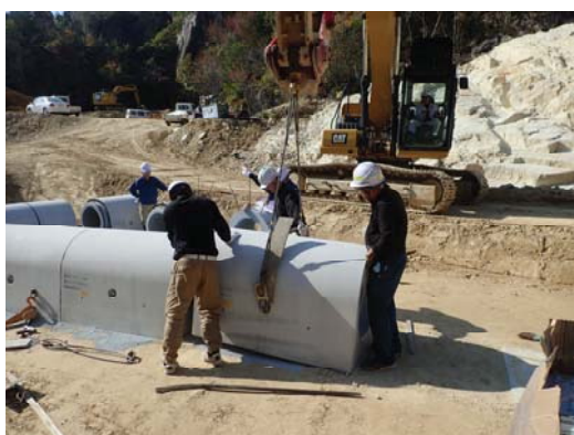
写真 33 PCa 底樋管据付状況
