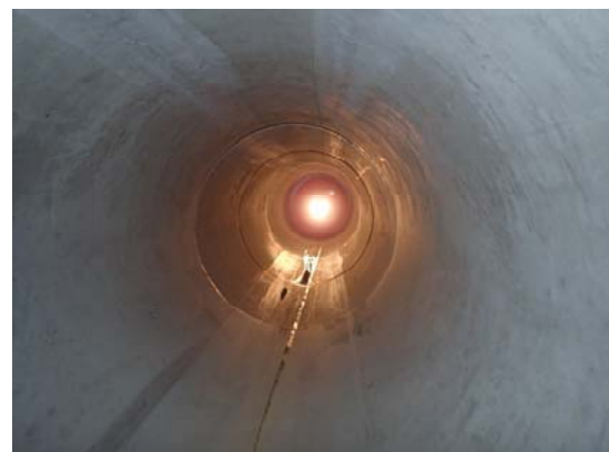
写真 37 管内調査状況
