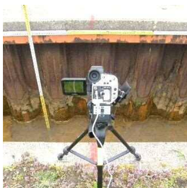
写真-10 赤外線サーモグラフィ による計測
