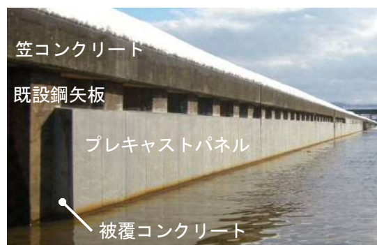
写真-3 本技術の施工事例
