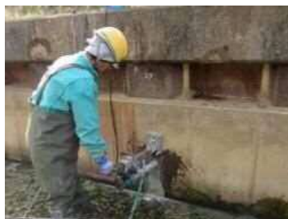
写真-27 鋼矢板のコア抜き状況
