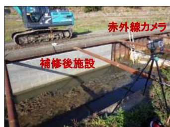
写真-11 赤外線カメラ設置状況
