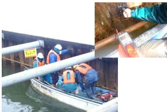
写真-9 超音波厚さ計による計測
