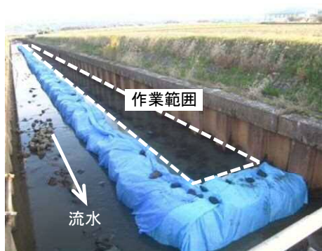
写真-7 大型土のうによる仮締切
