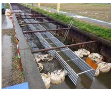
写真-23 鋼製組立式仮設水路
