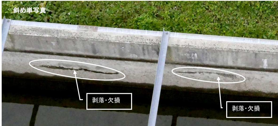
図7.17 コンクリート表面の剥落、欠損の検出例
