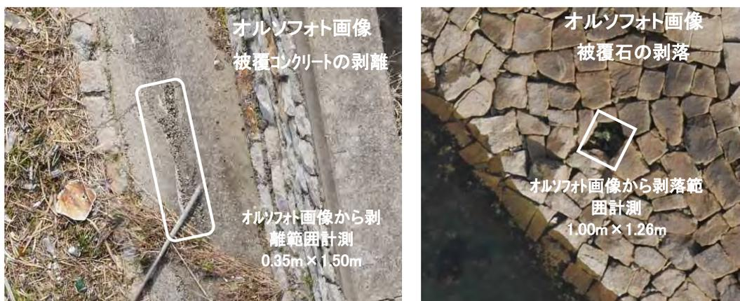
図7.4 剥離・剥落の検出例
