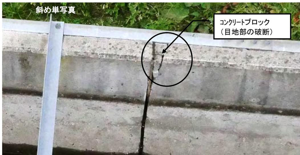
図7.14 目地部の損傷(破断)の検出例
