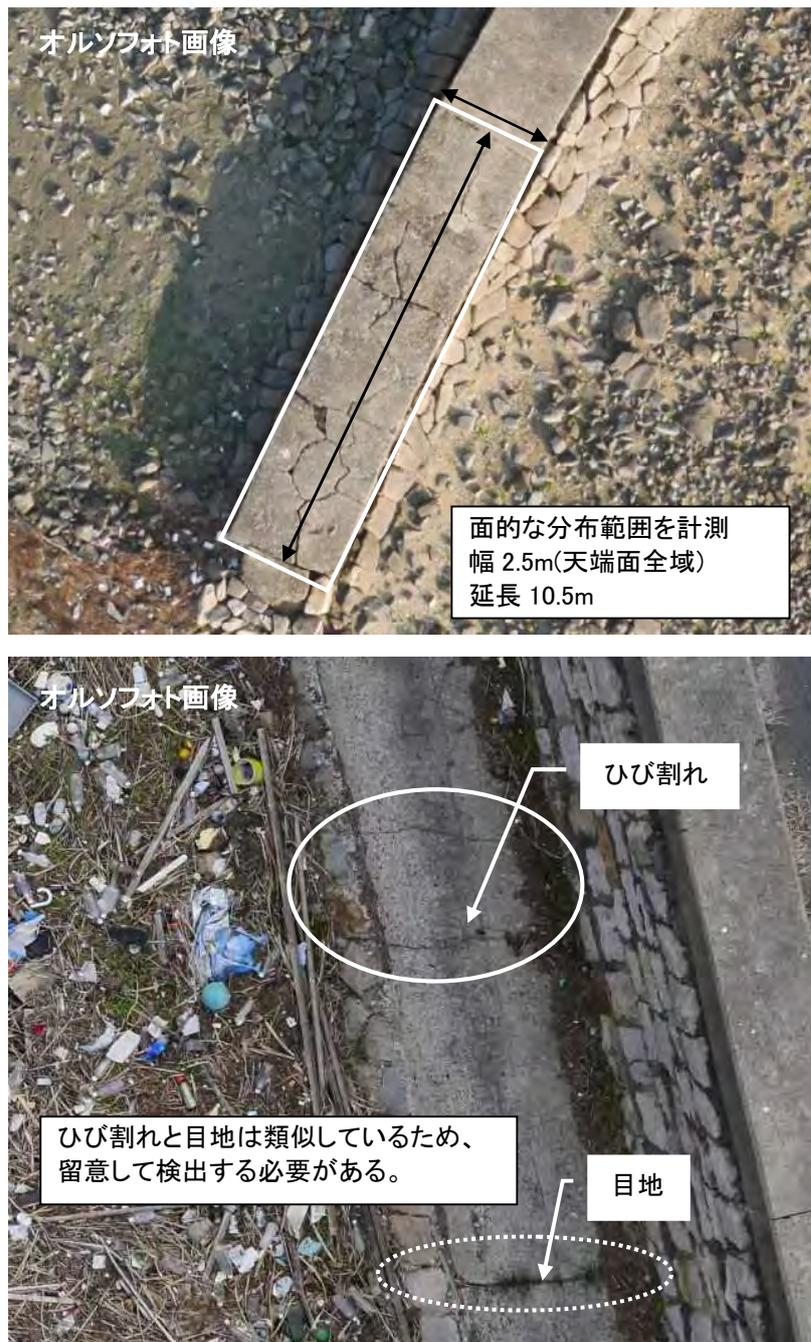
図7.2 ひび割れの検出例
