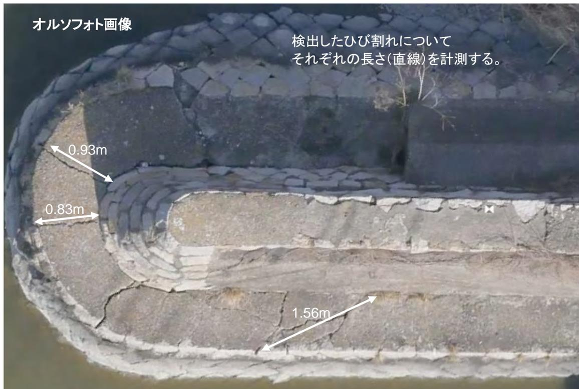
図7.3 ひび割れ長さの計測例
