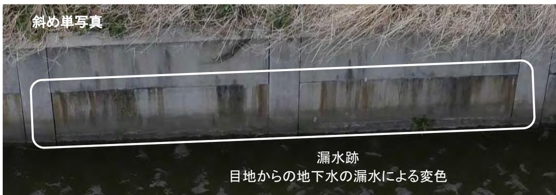
図7.24 地の劣化による漏水の痕跡
