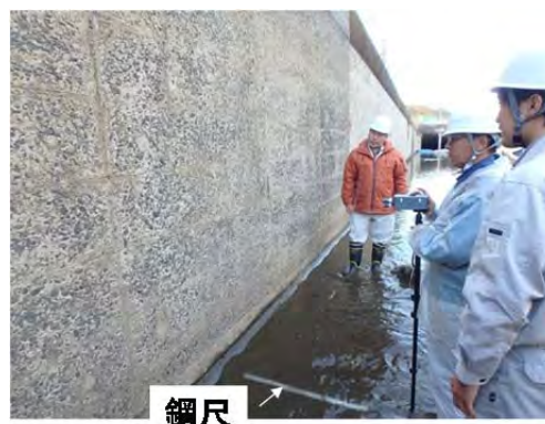
図 5.8 計測機の設置
