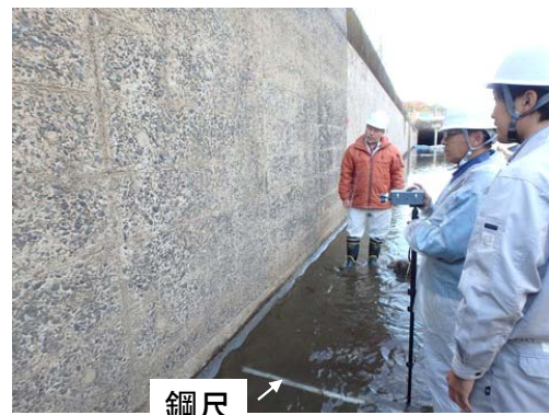
図 2. 1. 5 計測機の設置
