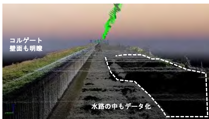
図1-8 八郎潟A地区の状況写真と斜め撮影による三次元モデルデータ
