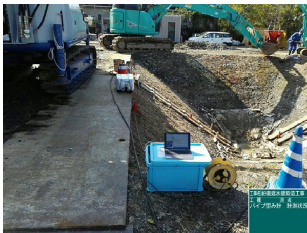
パイプ歪み計による計測状況
