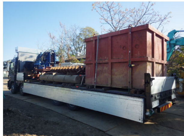
資機材搬出状況（函体・水槽）
