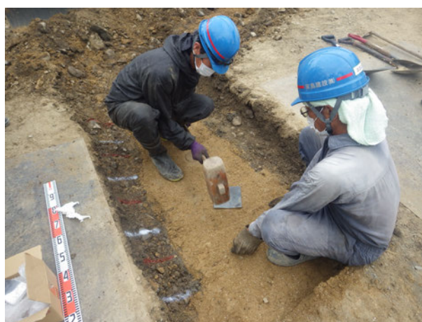
鉛直方向 コアサンプリング試料採取状況
