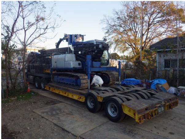
資機材搬出状況（杭打機）
