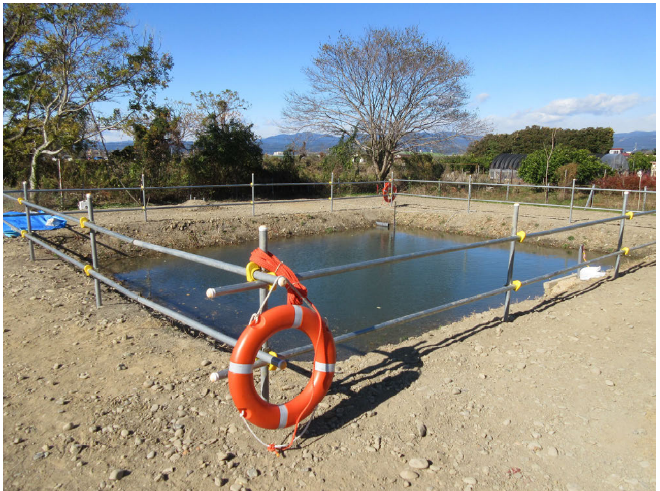
施工完了・ため池湛水完了
